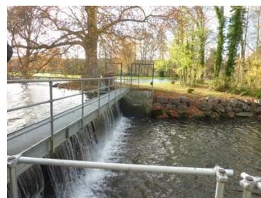
Schéma d'un barrage au fil de l'eau (*France Hydroélectricité*) et illustration avec du barrage de prise d'Heudreville-sur-Eure (*photos Pays du Bessin au Virois*). Cette centrale est équipée d'une vis d'Archimède.
