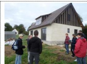
**Saint-Jean-le-Blanc.** Extension en ossature bois d'une maison traditionnelle en pierre. Toilettes sèches, chauffe-eau solaire thermique, enduits intérieur à la terre et extérieur à la chaux. Toiture en bardeaux de châtaignier.
