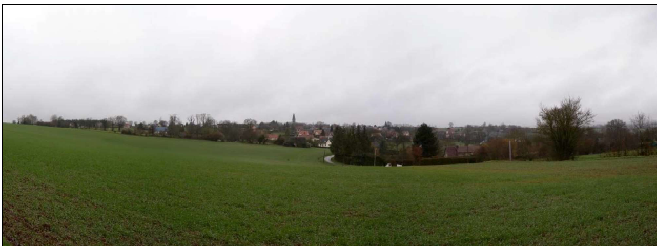
Nappes de pavillons descendant les pentes autour du bourg et du clocher
