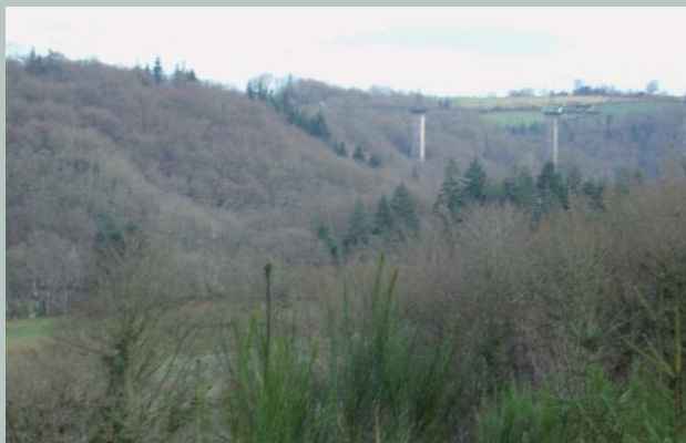
Viaduc de la Souleuvre
