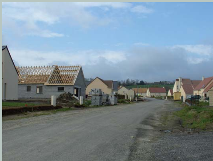
Lotissement - Commune de Vire
