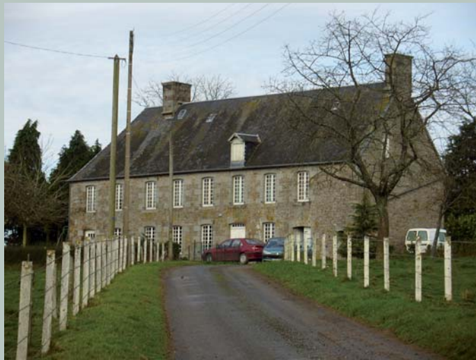
Exemple de bâti ancien en pierre en sortie ouest de Montchauvet.
