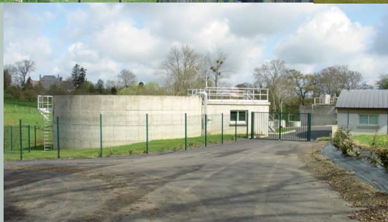
Station d'épuration de Saint-Sever-Calvados (Boues activées)
