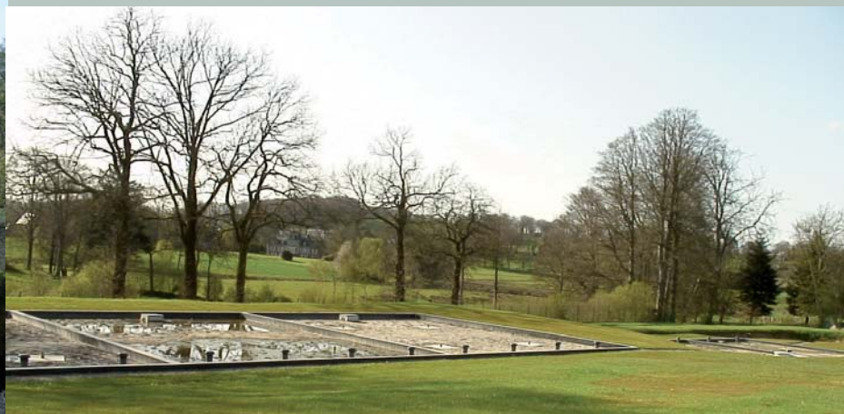
Station d'épuration de Maisonnelles-la-Jourdan (Filtres plantés de roseaux)
