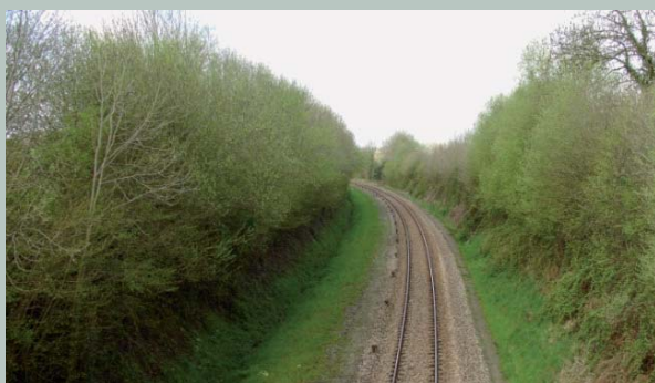
La traversée Est-Ouest du territoire par la voie de chemin de fer.
