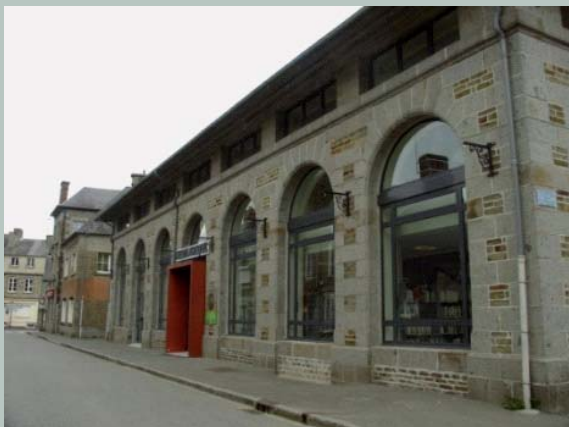
Médiathèque de Vassy, chaudière à bois
