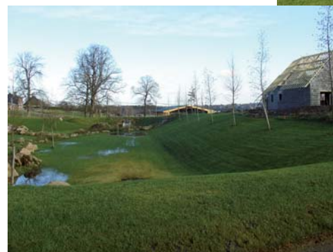
Opération intégrant la gestion des eaux pluviales
