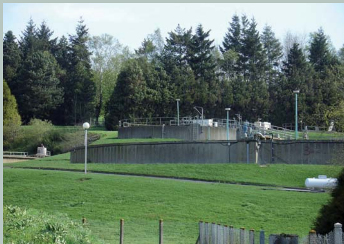
Station d'épuration de Vire (Boues activées)
