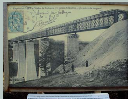
Le Viaduc de la Souleuvre
