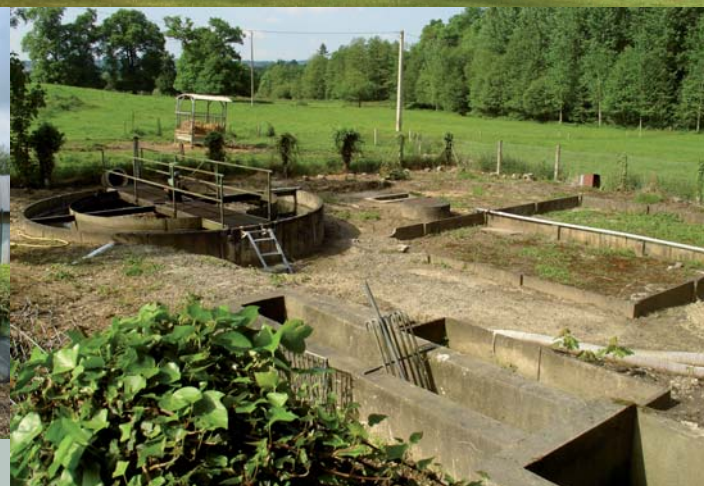
Ancienne station d'épuration de Landelles-et-Coupigny (hors service depuis 2010)
