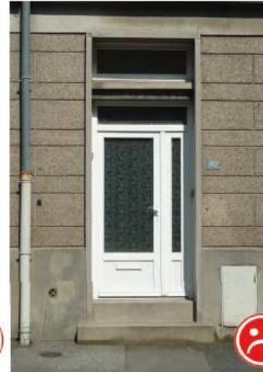
◀◀ Porte remplacée par un modèle en bois ne respectant pas les dessins traditionnels des portes de la Reconstruction.
