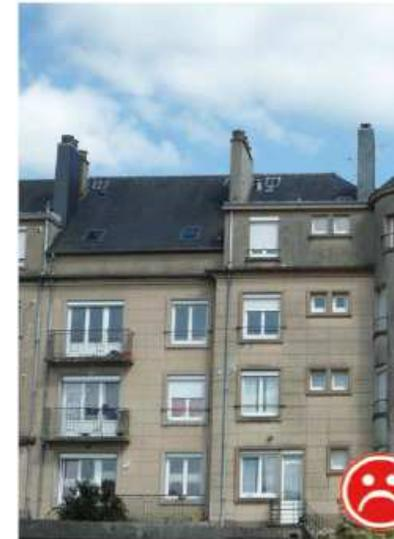
Sur ce même immeuble, les souches de cheminées ont été modifiées de façons différentes (enduit béton, essentage), rompant ainsi l'homogénéité du bâtiment
