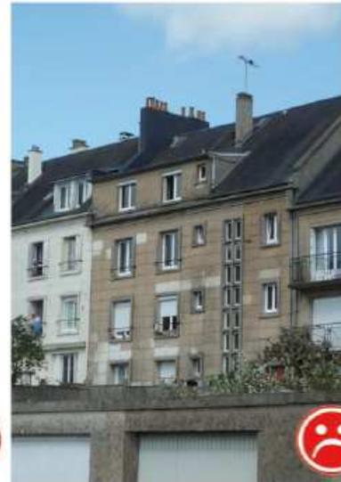
◀◀ *Éclatement des bétons lié à l'oxydation du ferrailage, et reprise en ciment des éléments de modénature.*
