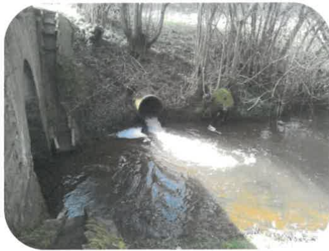
Photos illustrant les débordements latéraux et le pont busé infranchissable (IVN, 2023)
