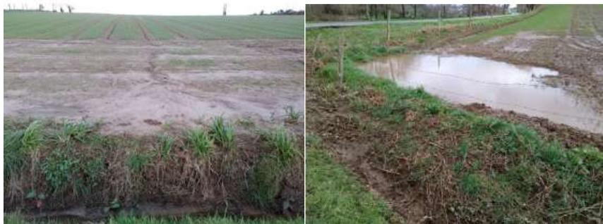
Exemple de site sur lequel un élément anti-érosif a été installé (à gauche, avant implantation du talus ; à droite, une fois le talus réalisé)
