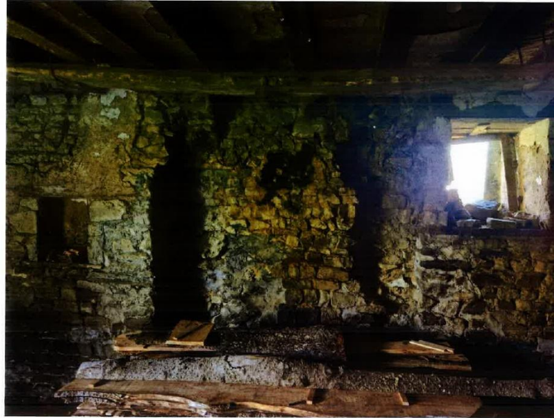
Conduit de cheminée
