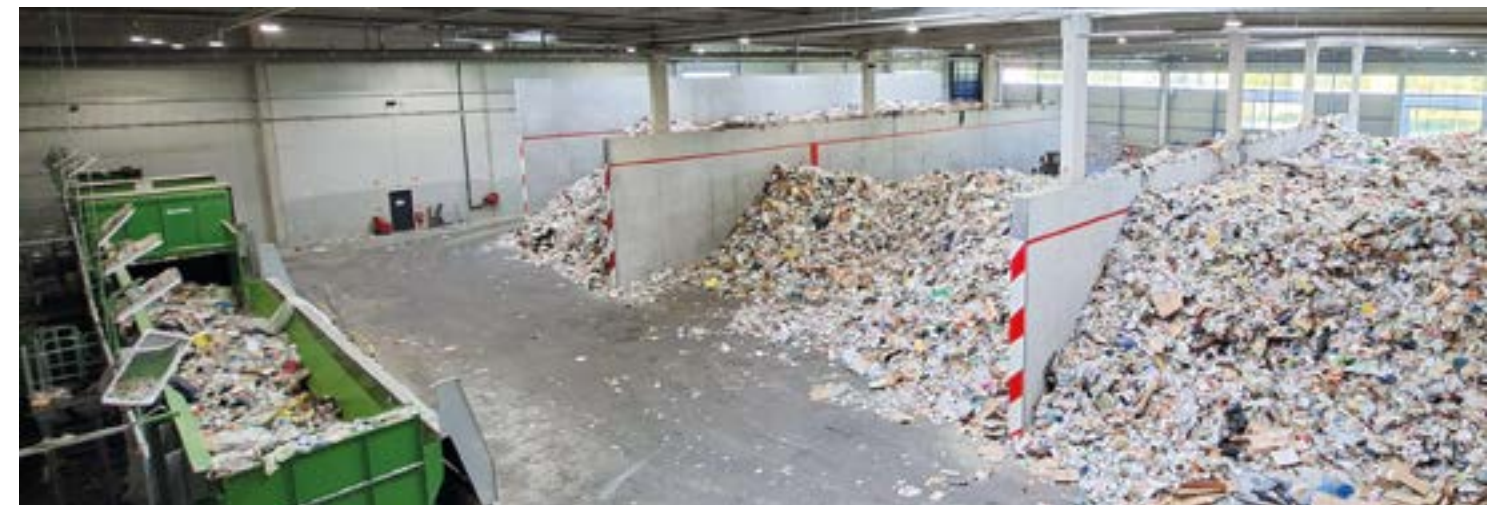
Normantri : zone de réception des déchets
