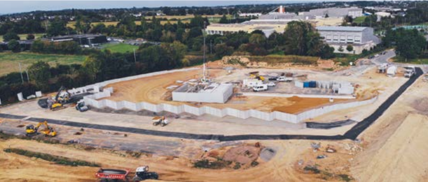
Nouvelle déchèterie de Bayeux - Avancement des travaux
