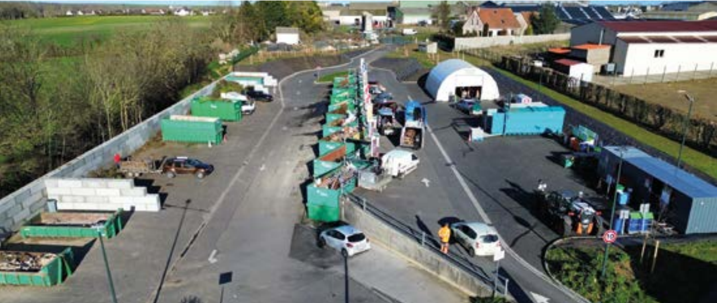
Déchèterie de Creully après travaux
