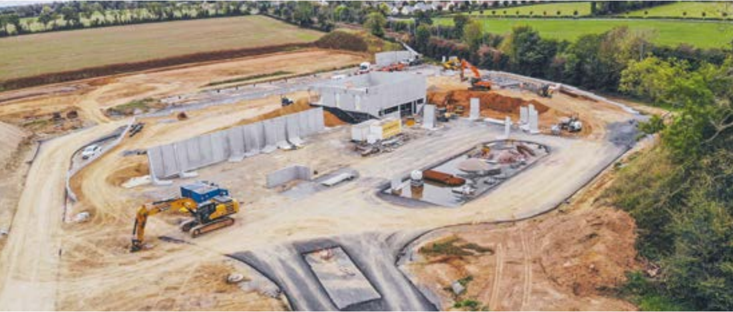
Nouvelle déchèterie de Bayeux - Avancement des travaux
