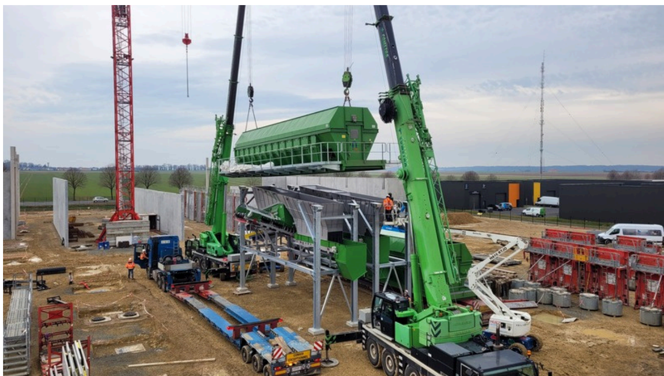
Février-mars 2025 : les machines de tri les plus imposantes sont installées avant la construction du bâtiment
